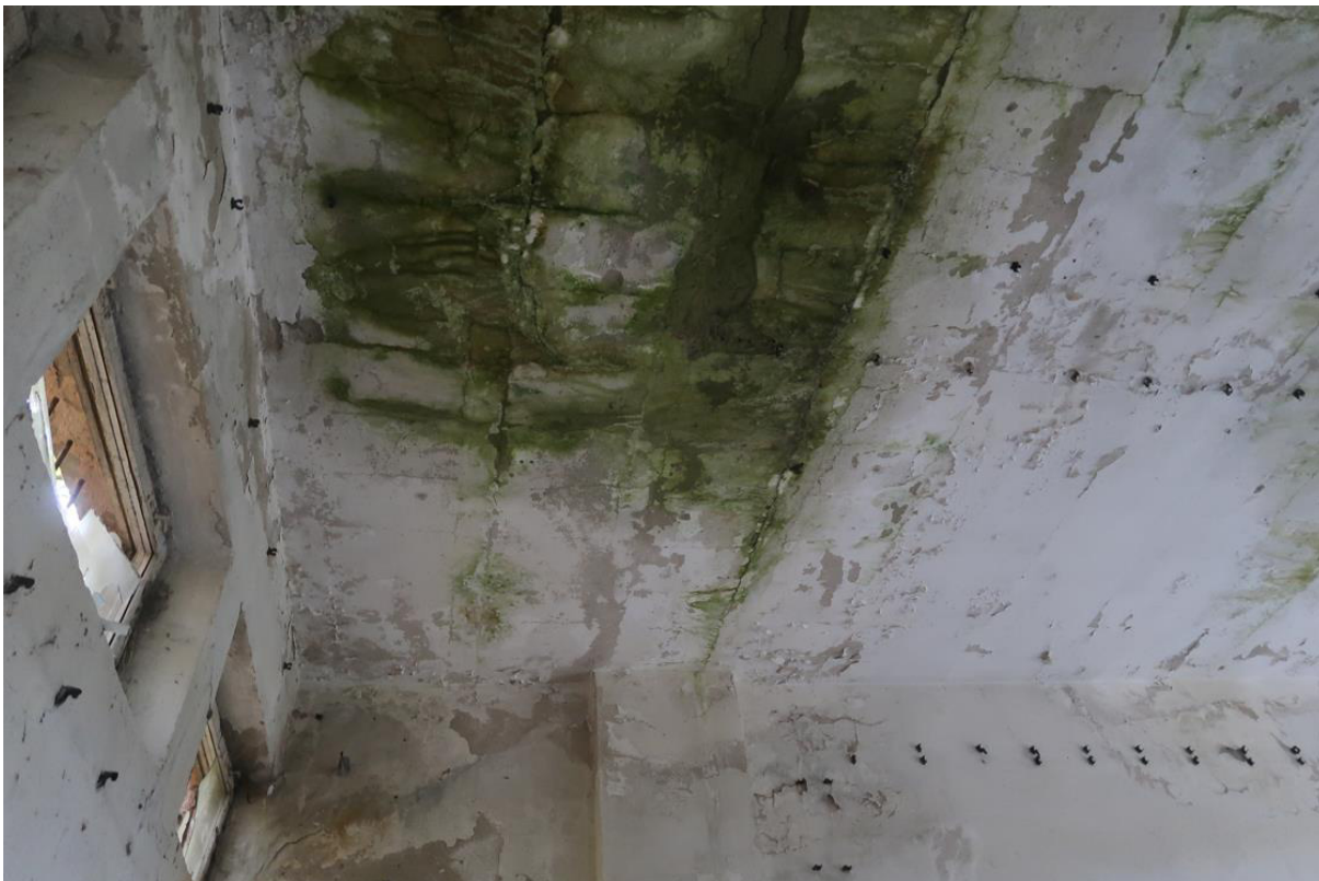
Fot. 33. Zaciek z zaglonieniem na suficie. Widoczne odparzenie powłoki malarskiej / tynku na suficie. W miejscu belek nośnych stropu widoczne zarysowania tynku.
