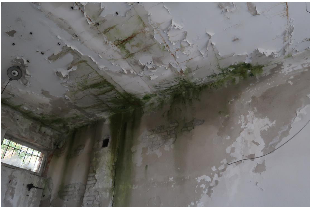
Fot. 32. Zaciek na suficie przechodzący na ścianę wewnętrzną. Widoczne odparzenie powłoki malarskiej / tynku na suficie i na ścianie. W miejscu belek nośnych stropu widoczne zarysowania tynku.
