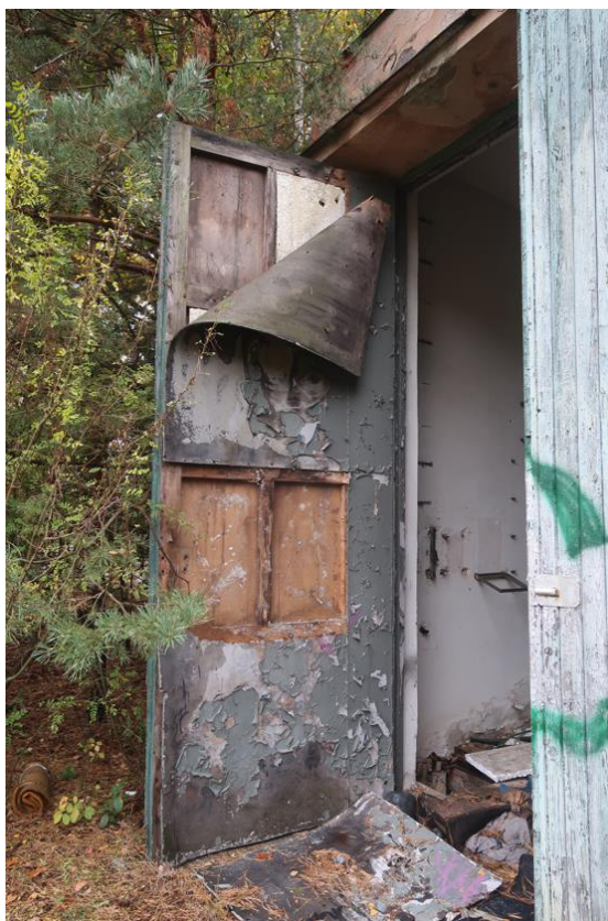
Fot. 46. Uszkodzone i zużyte drewniane drzwi garażowe, grożące przewróceniem.
