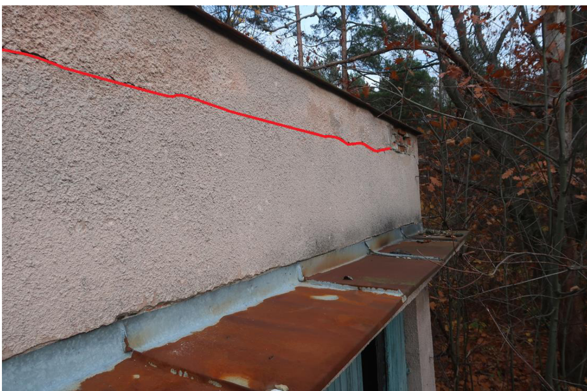
Fot. 13. Zarysowanie poziome na południowej elewacji w poziomie attyki.
