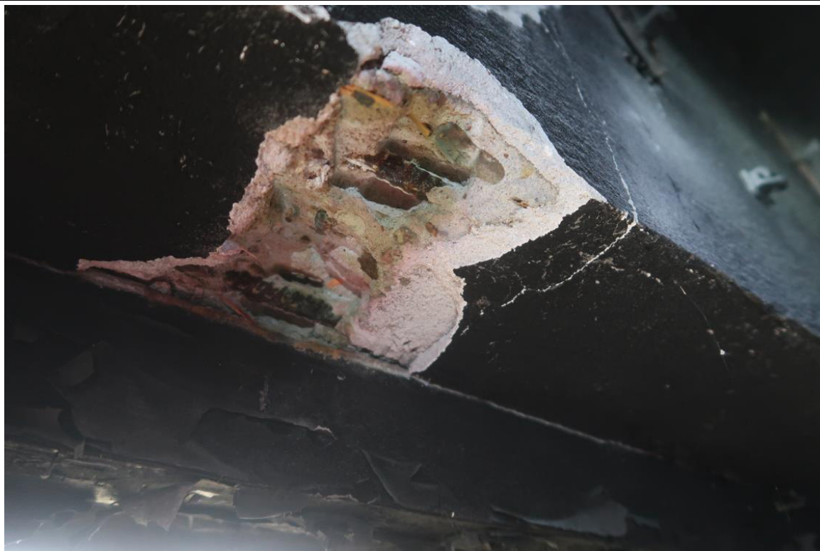
Fot. 23. Odkrywka O.9 nadproża. W odkrywce stwierdzono nadproże żelbetowe o przekroju 25x70cm, zbrojone podłużnie prętami żebrowanymi #12 i #14. Otulina zbrojenia wynosi 15÷30mm. Tynk c-w gr. 1,5cm. Lokalnie otulina jest odparzona, a zbrojenie skorodowane powierzchniowo. Występuje karbonatyzacja.
