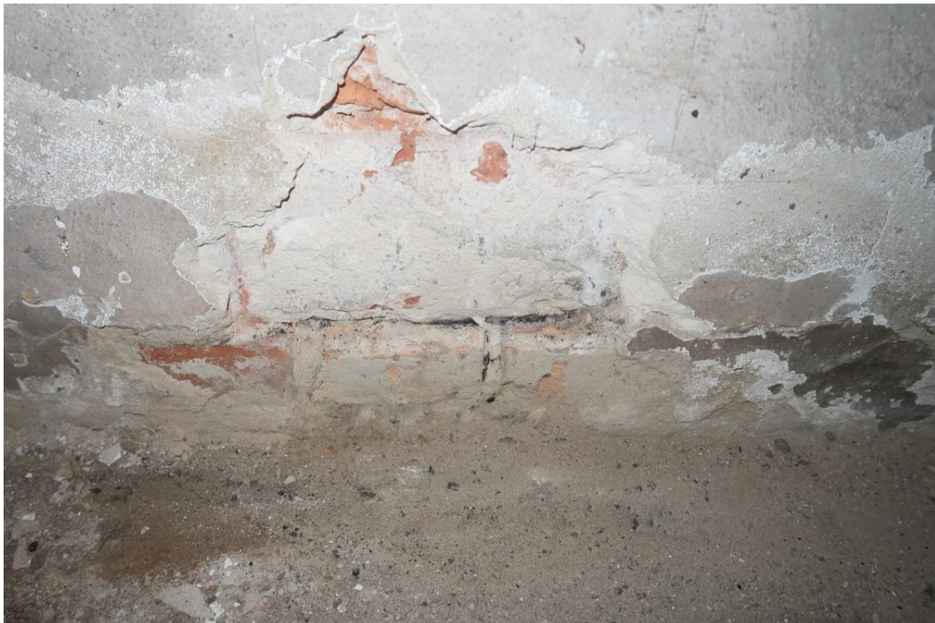
Fot. 9. Odkrywka O.7 ściany zewnętrznej. Stwierdzono konstrukcję ściany z pustaków kratowych murowanych na cegle ceramicznej, 1 warstwę nad posadzką betonową. Pomiędzy cegłą, a pustakami stwierdzono izolację p.wilgociową z masy bitumicznej / papy na lepiku. Tynk c-w gr. 2,0cm.
