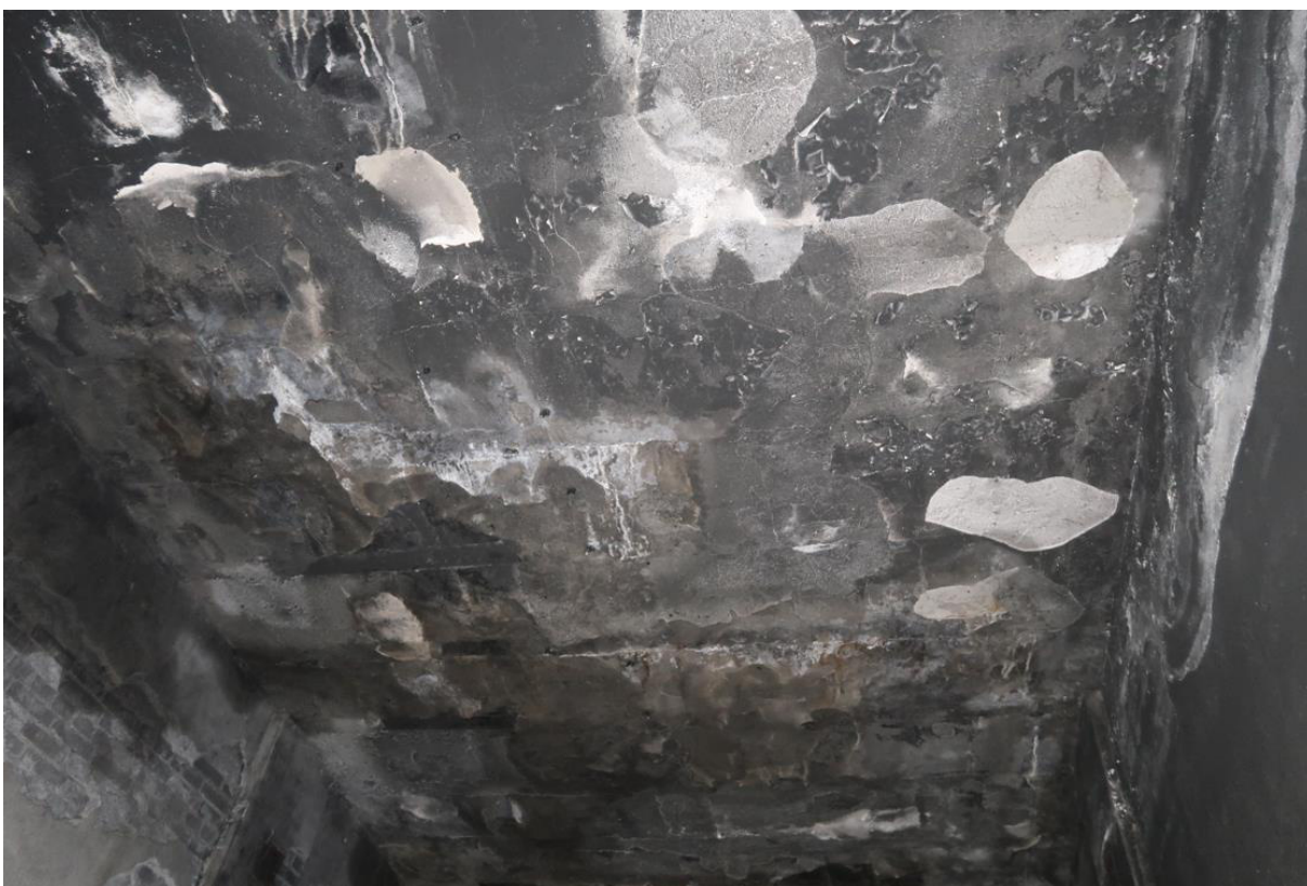
Fot. 34. Ślady po pożarze w postaci osmoleń na suficie wewnątrz budynku. Widoczne odparzenia powłoki malarskiej / tynku.
