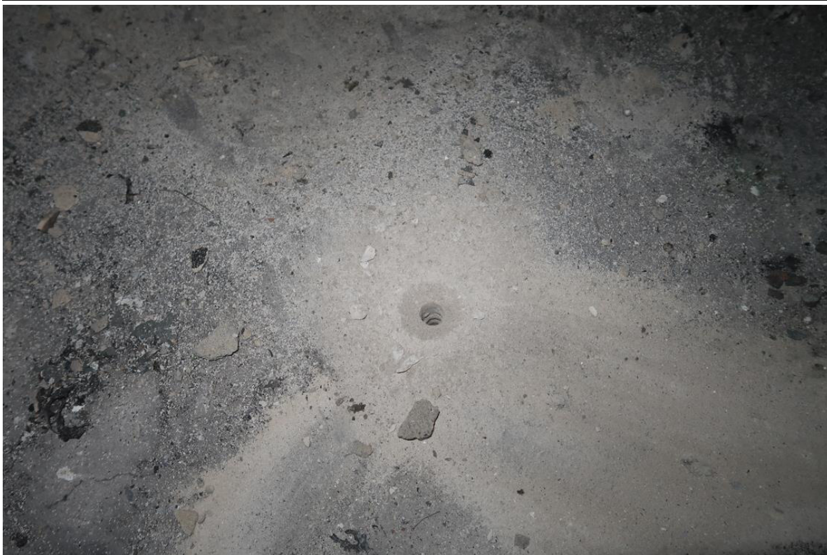
Fot. 40. Odkrywka O.5 posadzki. Stwierdzono płytę betonową gr. ~20cm.
