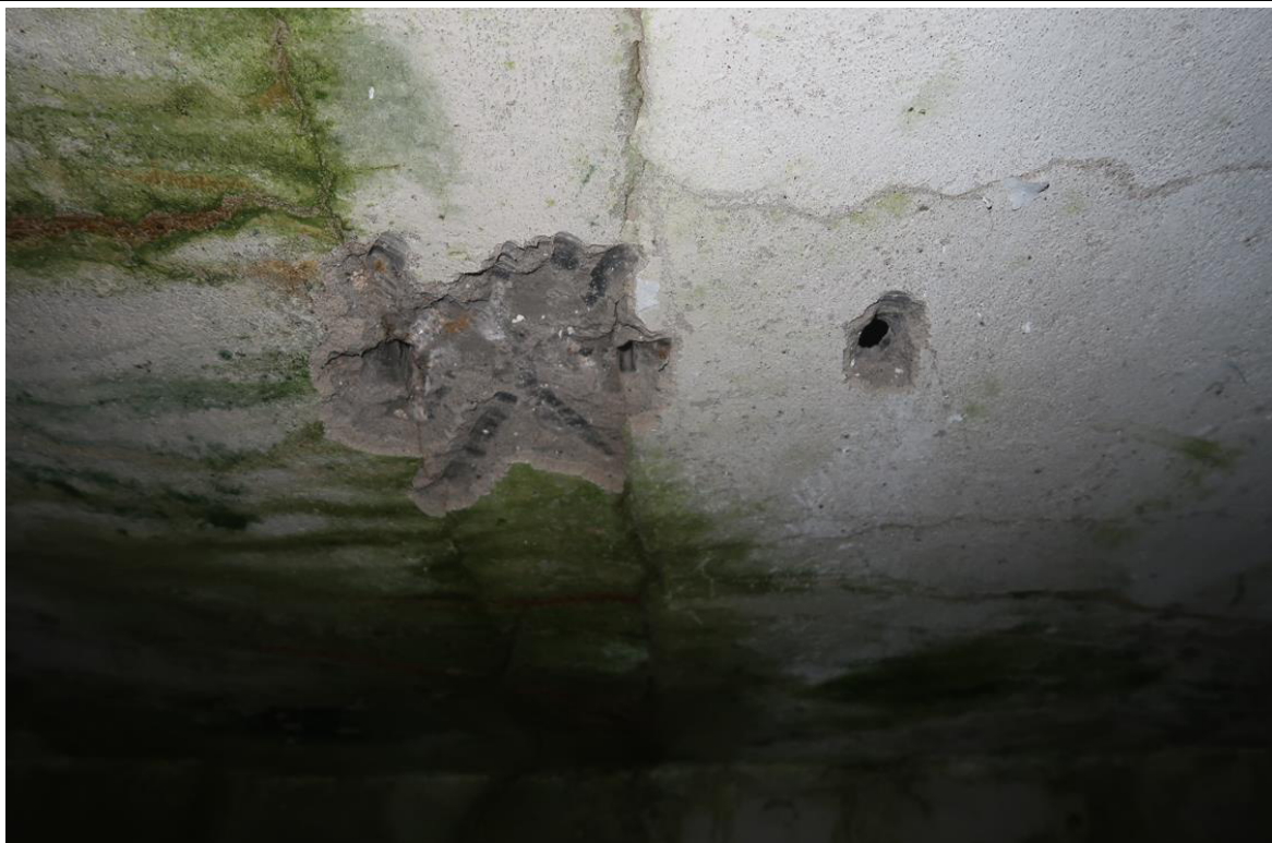
Fot. 27. Odkrywka O.1 stropu gęstożebrowego. Stwierdzono strop gęstożebrowy typu Teriva, z prefabrykowanymi belkami nośnymi szer.12cm w rozstawie co 60cm. Wysokość pustaka 19cm, a całkowitą grubość stropu oszacowano na 24cm. Tynk c-w gr. 1,0cm, lokalnie odparzony.
