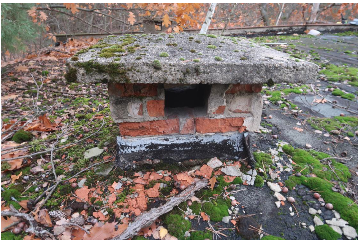
Fot. 47. Erozja czapy kominowej i cegieł komina. Widoczne ubytki tynku i cegły z komina leżące na pokryciu stropodachu.
