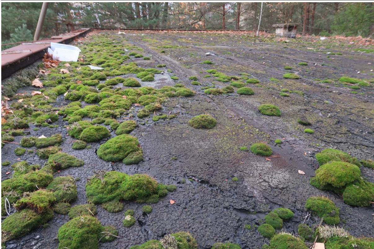
Fot. 39. Zużyte pokrycie stropodachu z papy.
