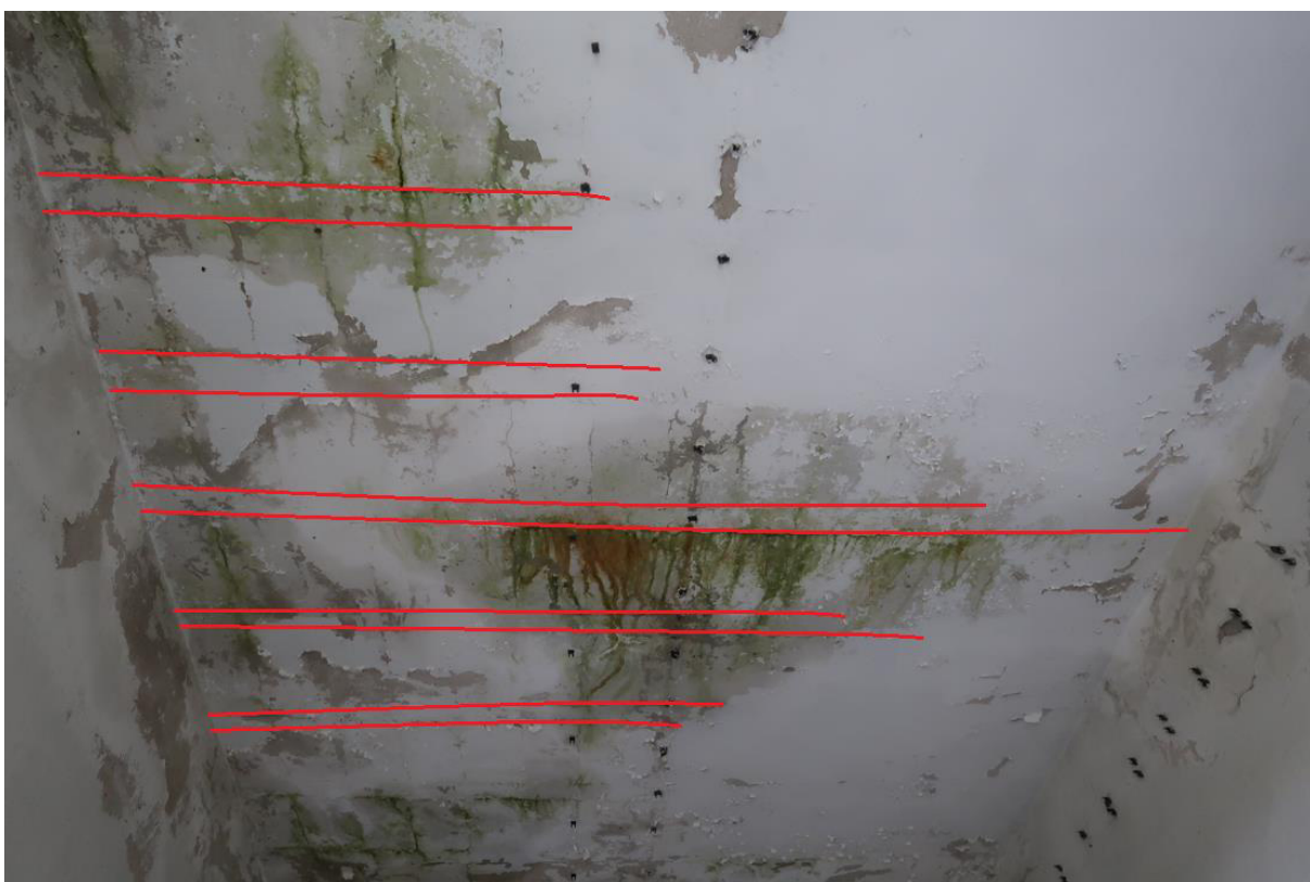
Fot. 36. Zarysowania na suficie w miejscu belek nośnych stropu gęstożebrowego. Widoczne zacieki na suficie oraz odparzona powłoka malarska / tynk.
