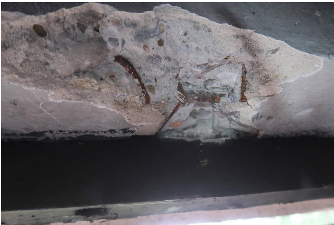
Fot. 24. Odkrywka O.10 nadproża. W odkrywce stwierdzono nadproże żelbetowe o przekroju 25x68cm, zbrojone podłużnie prętami żebrowanymi #12. Otulina zbrojenia wynosi 15mm. Tynk c-w gr. 1,0cm. Zbrojenie jest skorodowane powierzchniowo. Występuje karbonatyzacja.
