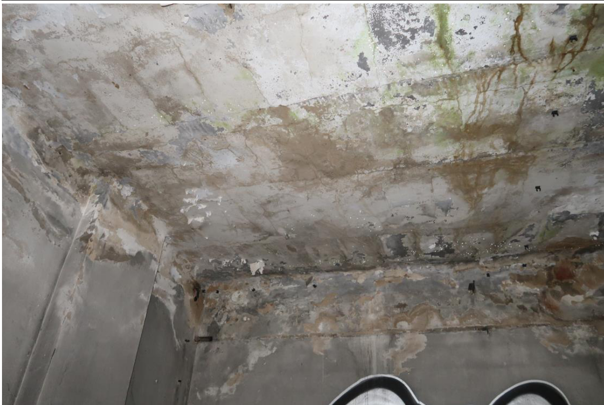
Fot. 35. Zaciek na suficie. Widoczne odparzenie powłoki malarskiej / tynku na suficie. W miejscu belek nośnych stropu widoczne zarysowania tynku.
