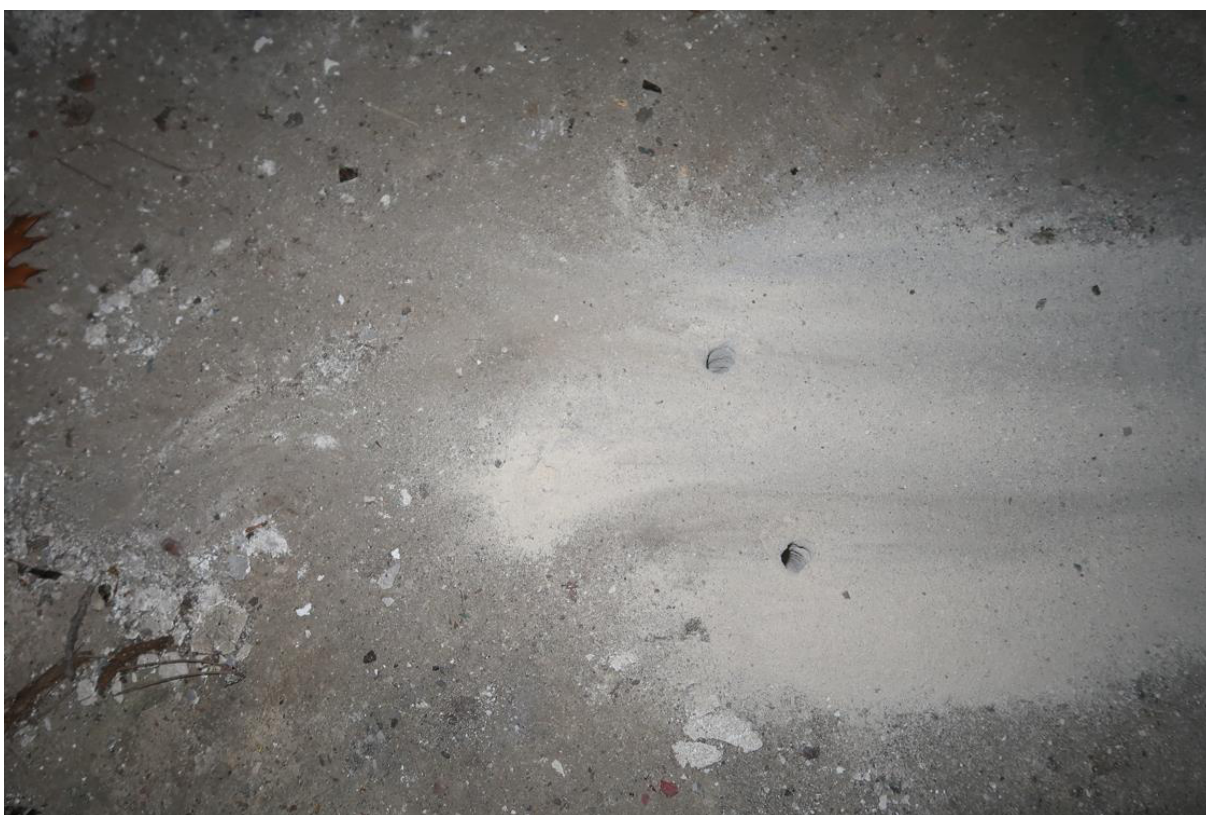
Fot. 41. Odkrywka O.8 posadzki. Stwierdzono płytę betonową gr. ~20cm.
