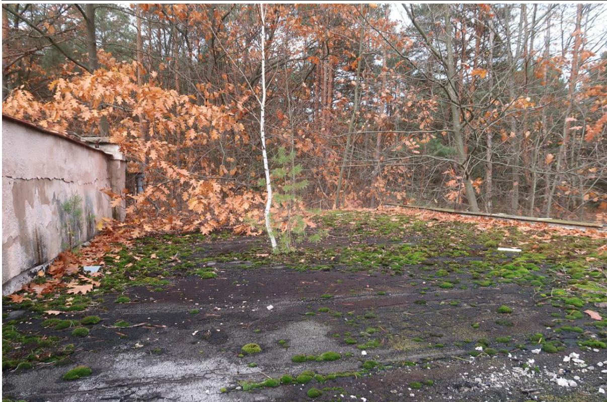
Fot. 37. Stropodach pokryty papą. Widoczne zużycie pokrycia z papy oraz porastająca roślinność na stropodachu części niższej.
