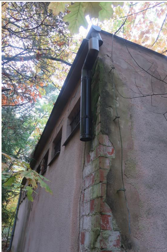
Fot. 16. Odparzony tynk i zagłobienie na północno-zachodnim narożniku elewacji w miejscu częściowo zdemontowanej rury spustowej.
