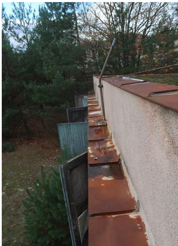
Fot. 50. Korozja obróbek blacharskich i pozostałości po instalacji odgromowej.
