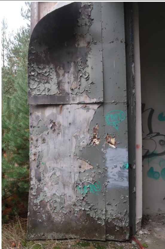
Fot. 45. Uszkodzone i zużyte drewniane drzwi garażowe, grożące przewróceniem.
