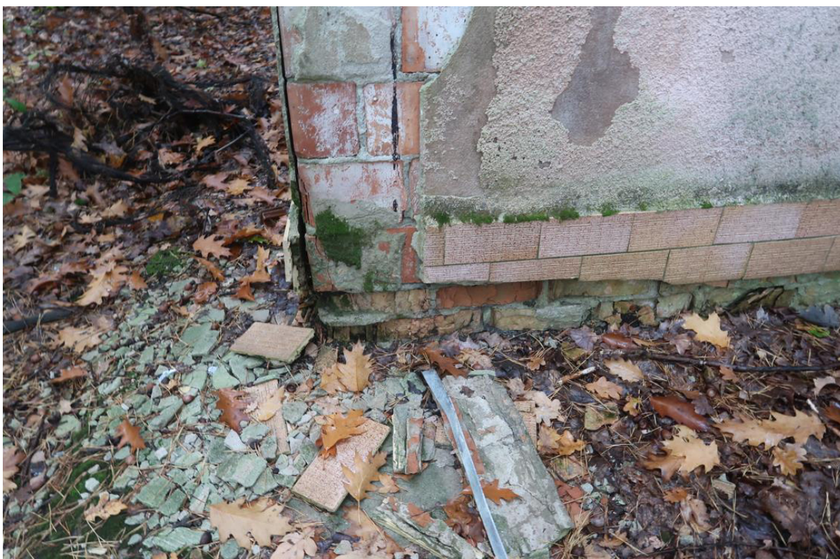
Fot. 11. Odparzony tynk i płytki cokołu na zachodniej elewacji. Widoczna erozja cegły ściany fundamentowej w poziomie cokołu oraz pustaki kratowe powyżej.
