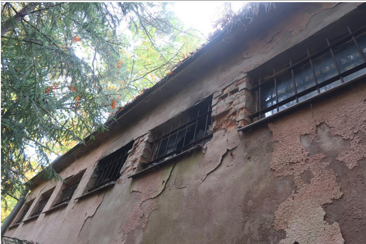
Fot. 14. Odparzony tynk i erozja cegieł w filarkach międzyokiennych na północnej elewacji.
