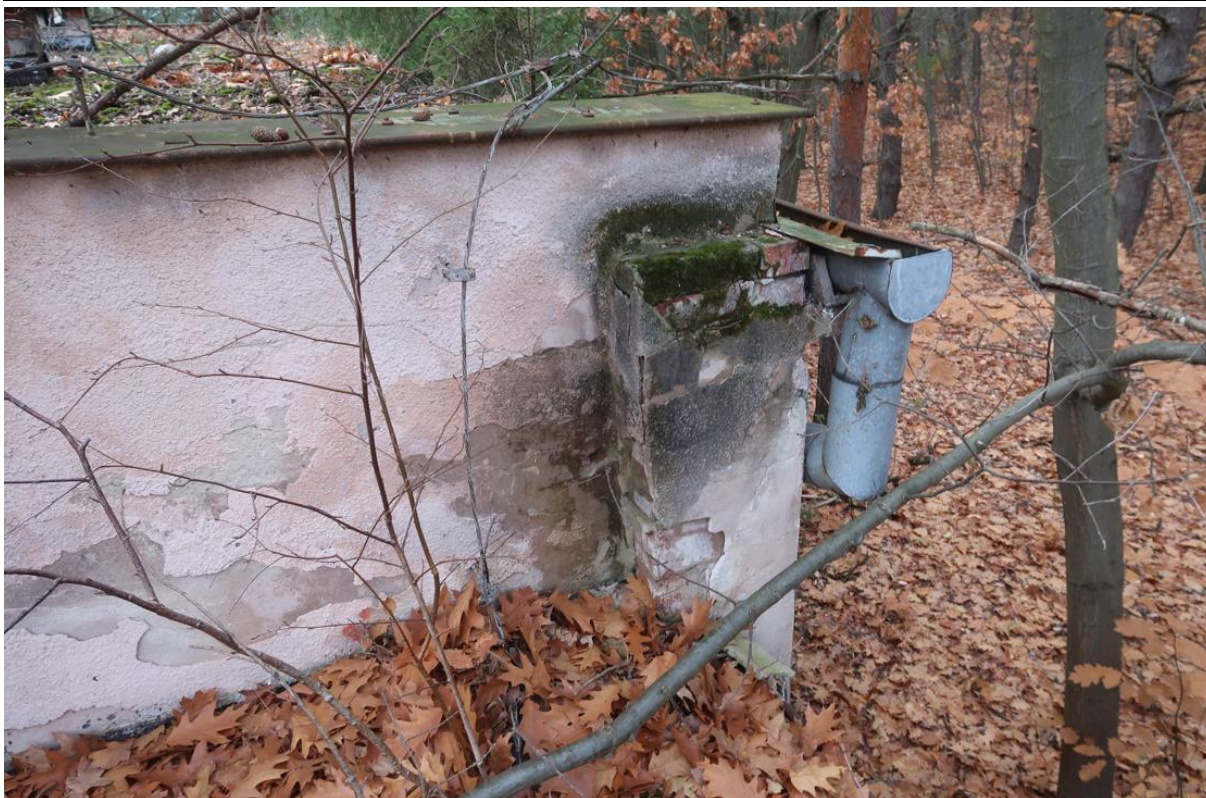
Fot. 18. Odparzony tynk, zagłonicie i erozja cegieł oraz pustaków na ścianie w poziomie stropodachu na styku części wyższej i niższej.
