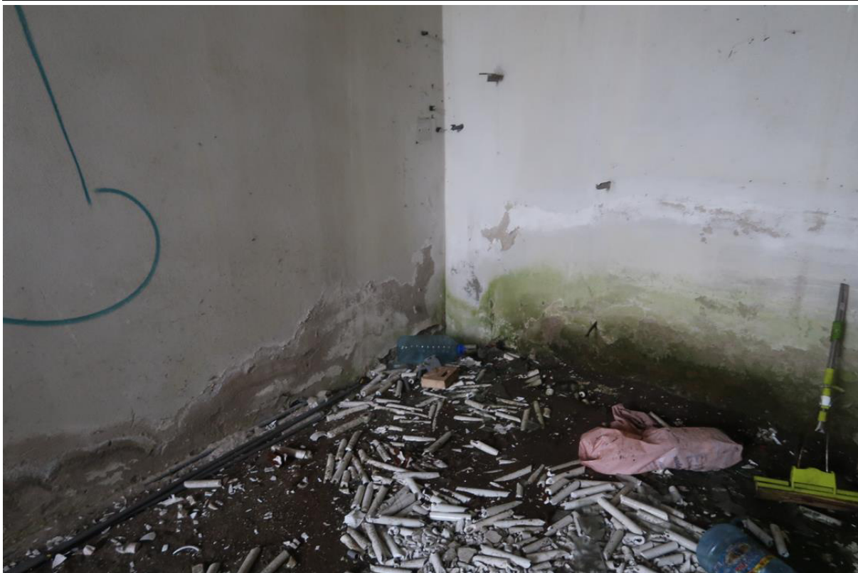
Fot. 20. Odparzona powłoka malarska / tynk w dolnej partii ściany w jednym z pomieszczeń wewnątrz budynku. Widoczne wysolenia i zagłonicenia na tynku.
