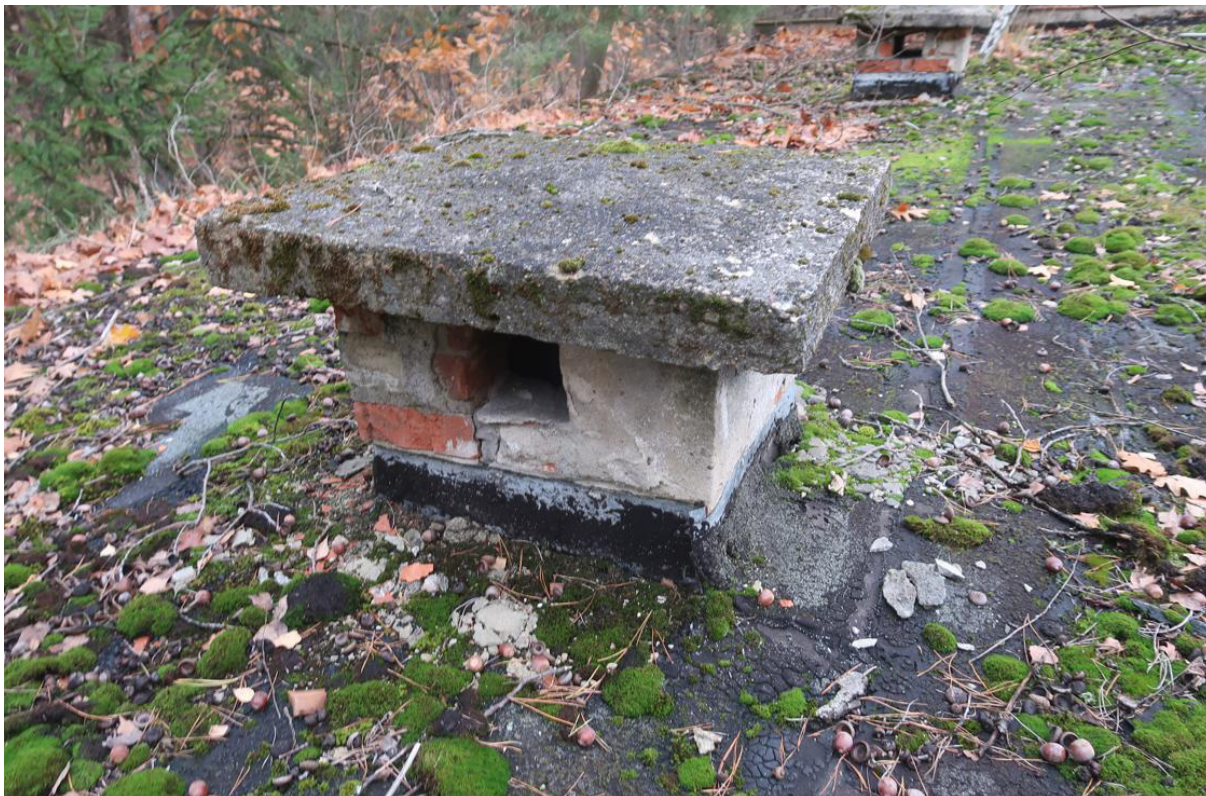
Fot. 48. Erozja czapy kominowej i cegieł komina. Widoczne ubytki tynku i cegły z komina leżące na pokryciu stropodachu.
