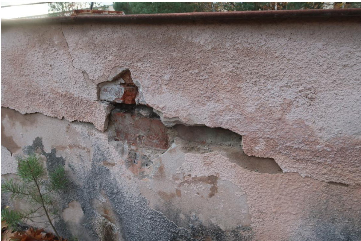
Fot. 10. Odkrywka O.11 ściany zewnętrznej. Stwierdzono konstrukcję ściany attyki z ceramicznej cegły pełnej, murowanej na ścianie z pustaków kratowych.
