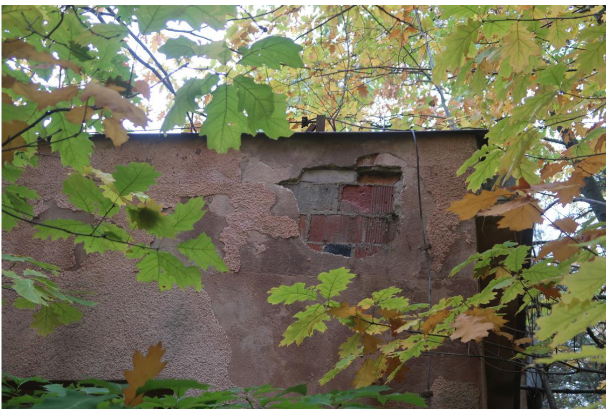
Fot. 15. Odparzony tynk i widoczna erozja pustaków kratowych na południowej elewacji.
