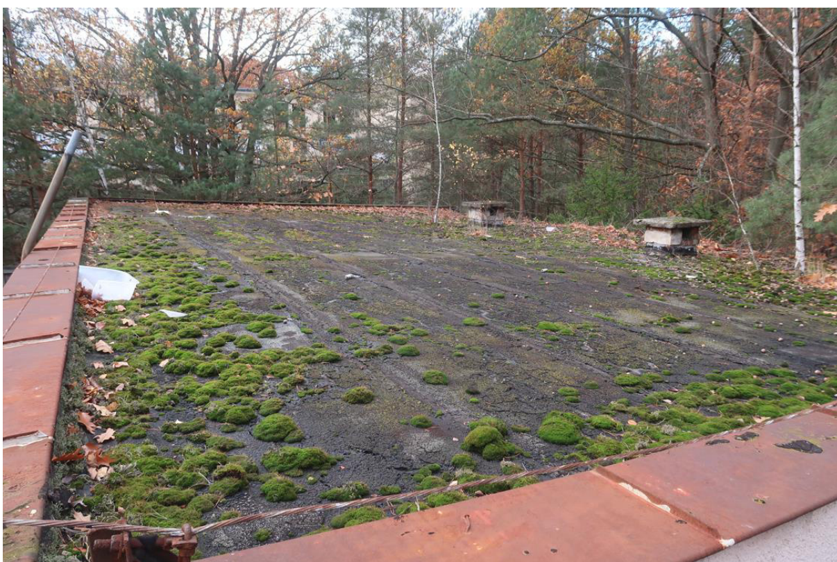
Fot. 38. Stropodach pokryty papą. Widoczne zużycie pokrycia z papy oraz porastająca roślinność na stropodachu części wyższej.
