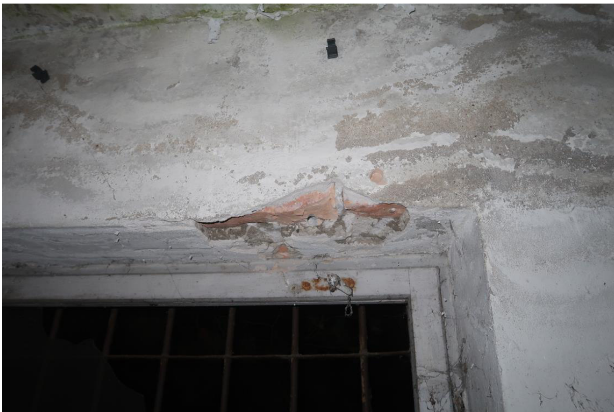
Fot. 22. Odkrywka O.3 nadproża. Stwierdzono nadproże ceglane płaskie, zbrojone.
