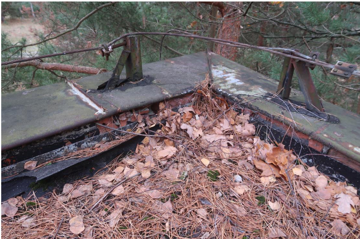
Fot. 49. Korozja obróbek blacharskich i pozostałości po instalacji odgromowej.
