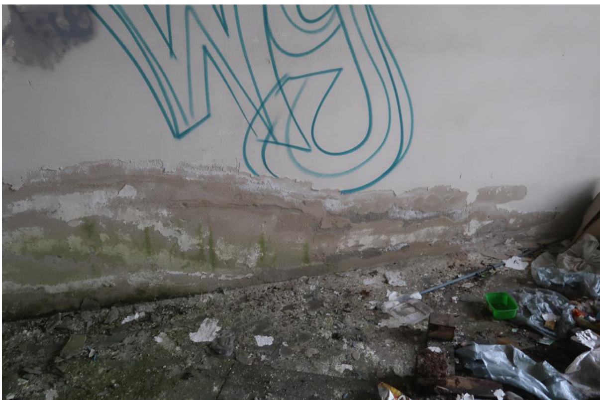
Fot. 19. Odparzona powłoka malarska / tynk w dolnej partii ściany w jednym z pomieszczeń wewnątrz budynku. Widoczne wysolenia i zagłonicia na tynku.
