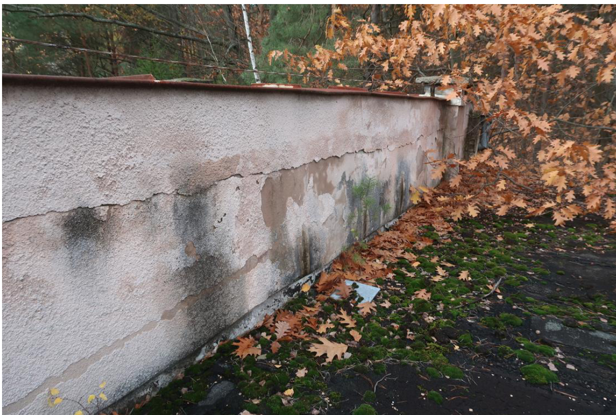
Fot. 17. Odparzony tynk i zarysowanie poziome na attyce, w miejscu styku części wyższej i niższej budynku.
