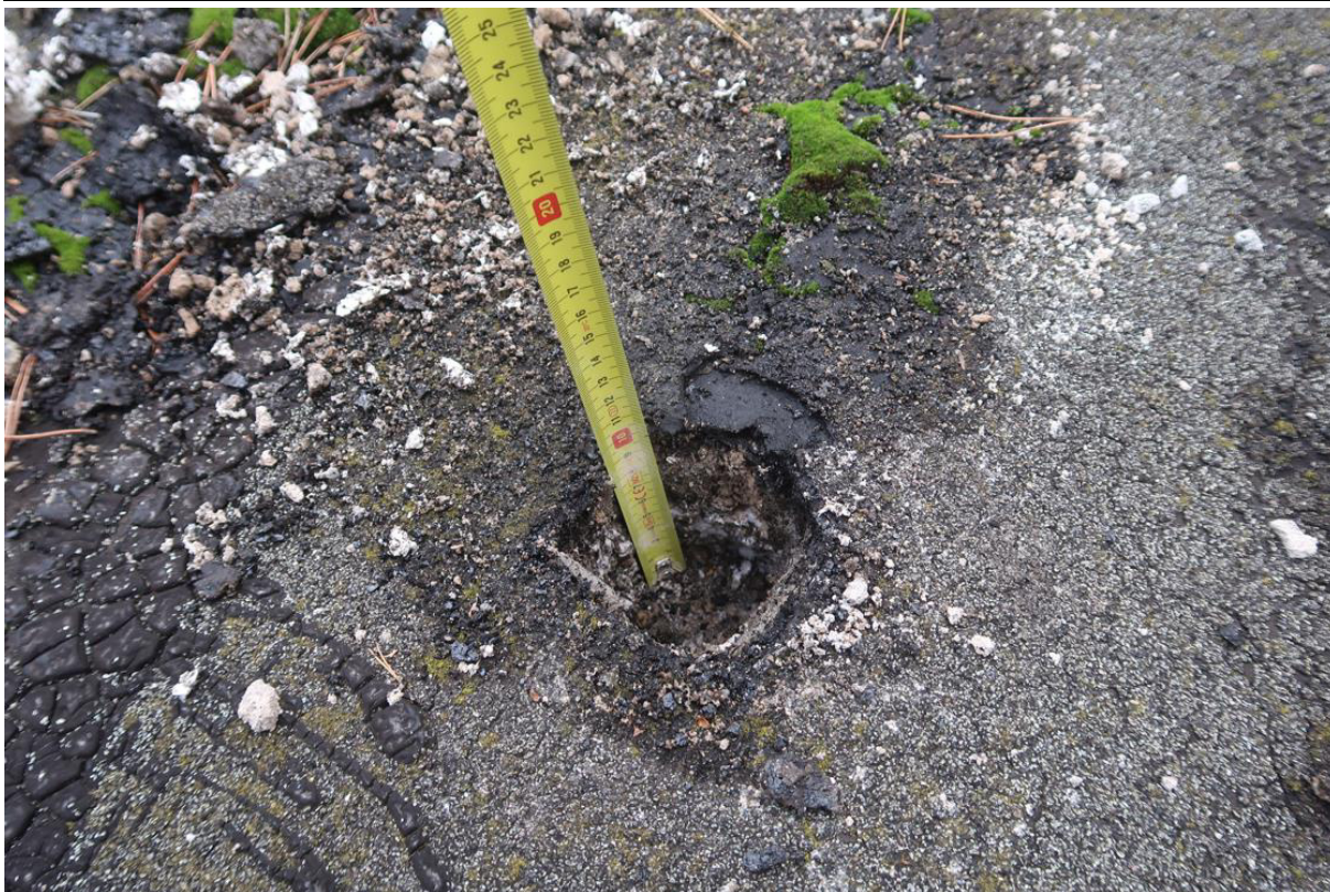
Fot. 31. Odkrywka O.13 stropodachu. W odkrywce stwierdzono pokrycie z 2x papy, termoizolację ze styropianu gr. 8cm oraz folie PE ułożoną bezpośrednio na stropie gęstożebrowym. Na folii stwierdzono duże zawilgocenie.
