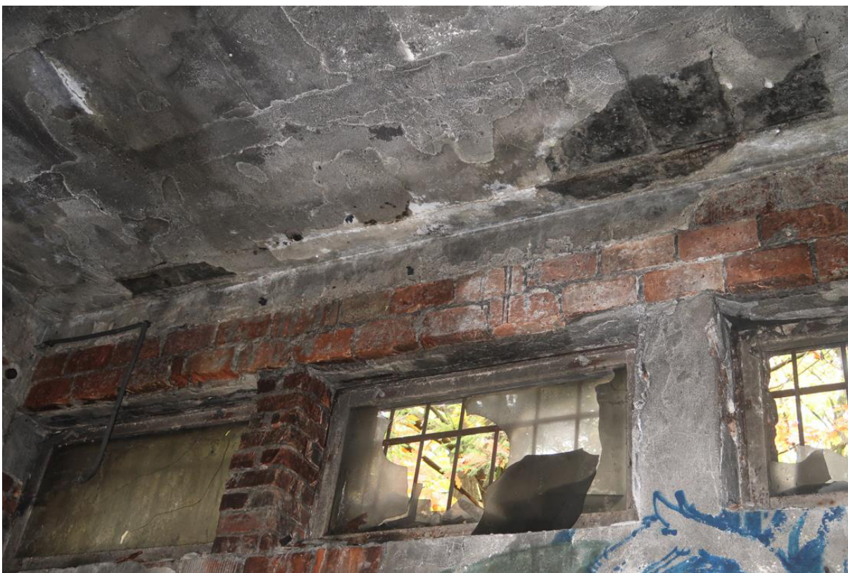
Fot. 26. Odparzony tynk na nadprożach wewnątrz budynku. Widoczne osmolenia ścian i nadproży po pożarze.
