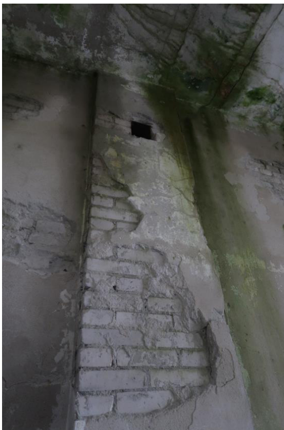
Fot. 21. Odparzony tynk i zagłonicie na ścianie w rejonie komina wewnątrz budynku. Widoczna konstrukcja komina z cegły wapienno-piaskowej.
