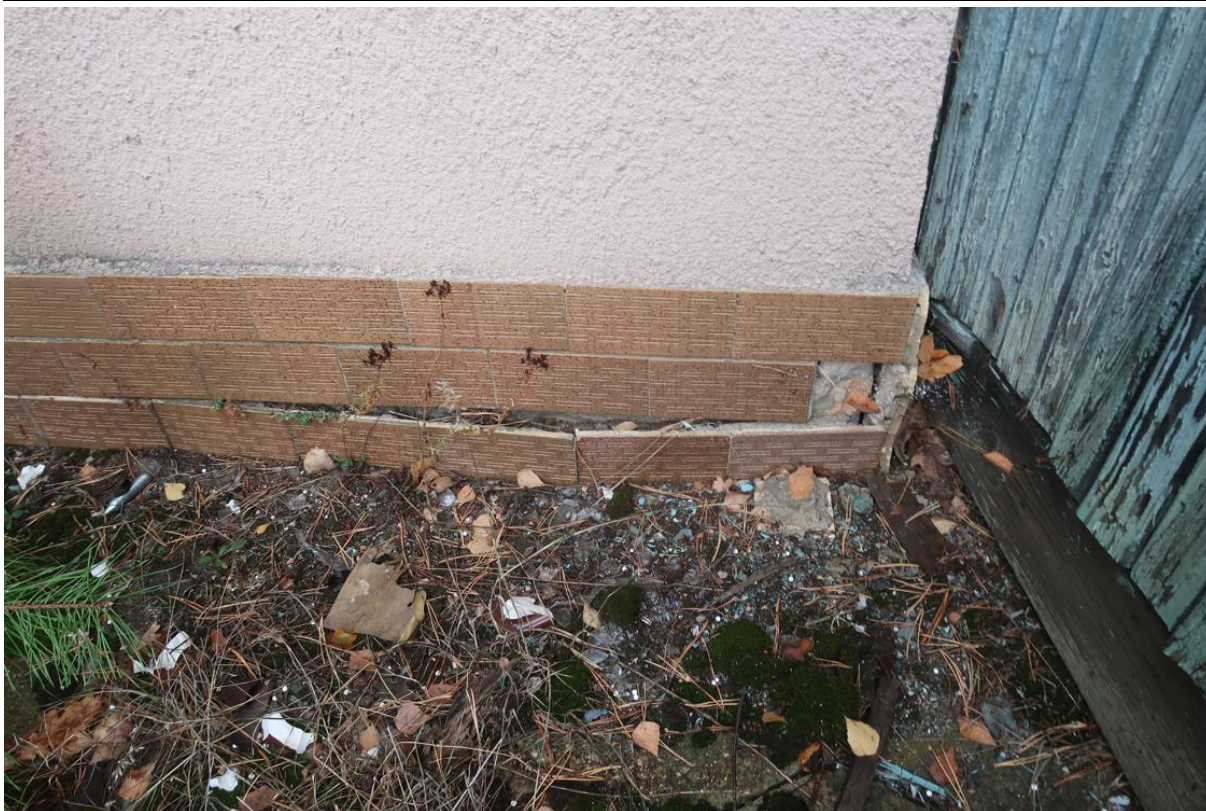
Fot. 12. Odparzone płytki cokołu na południowej elewacji.
