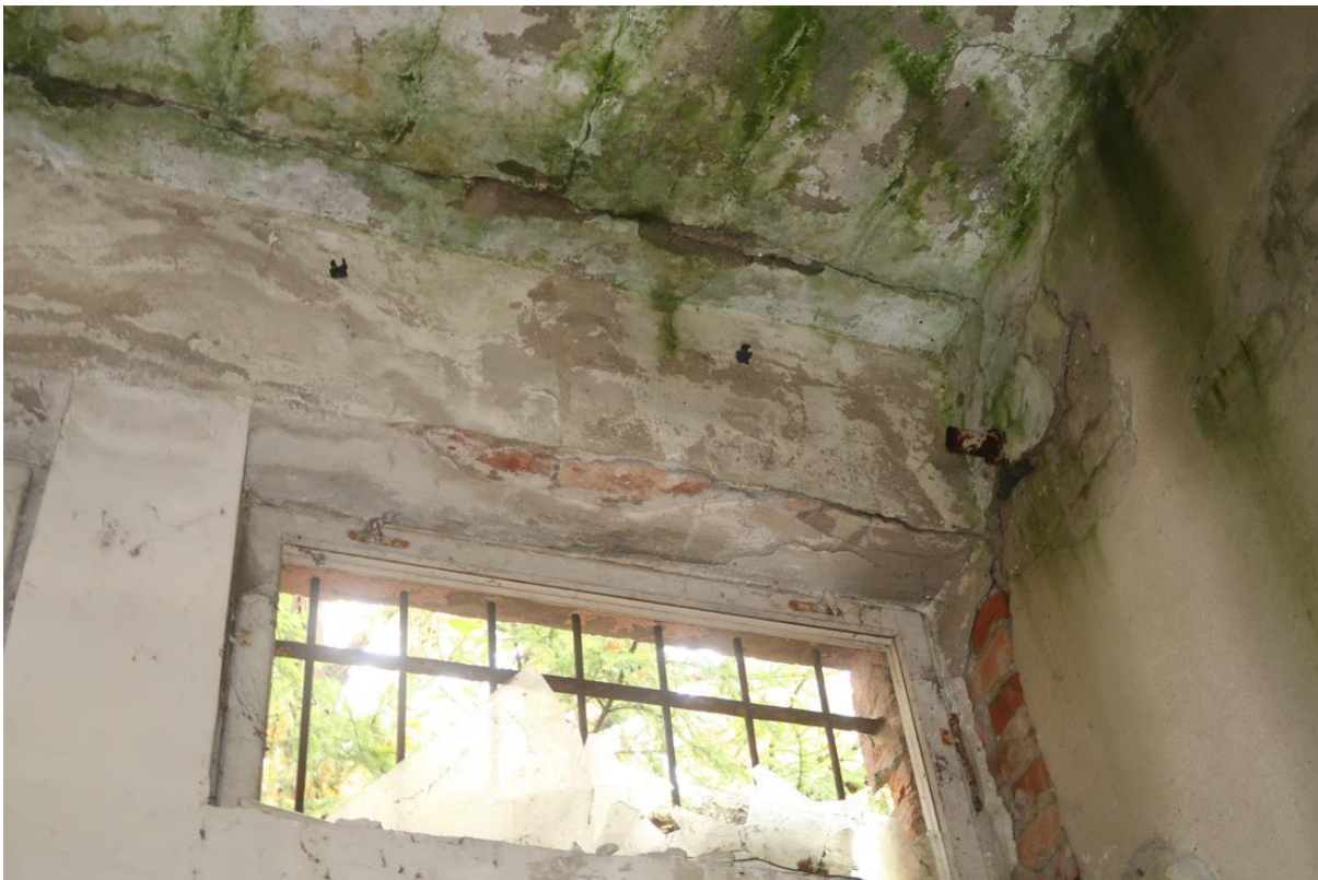
Fot. 25. Odparzony tynk na nadprożu wewnątrz budynku. Widoczne nadproże płaskie, ceglane.
